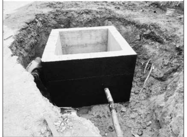
DC27 - montat conductă PEHD 110 mm și 3 subtraversări.
