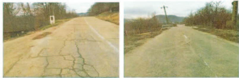
Situația existentă pe DJ 605C
